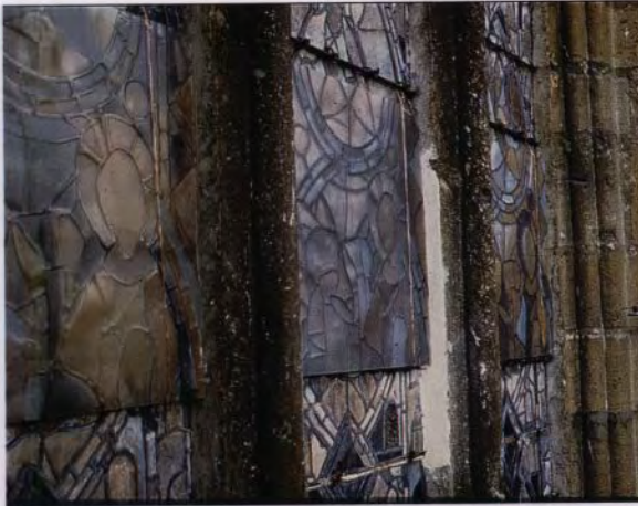
Fig. 6: Vitrages de protection en verre thermoformé. Dispositif expérimental avec verres teintés de manière plus ou moins soutenue. Tours, cathédrale, fenêtre H I, 3a-c.
