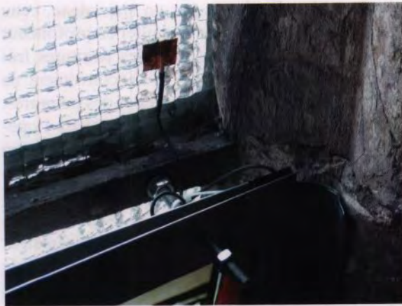
Fig. 4: Dispositif de vitrages de protection, avec panneau original déplacé vers l'intérieur et points de mesure pour la surveillance des conditions climatiques. Francfort sur l'Oder, église Notre-Dame, fenêtre est, I, 3b.
